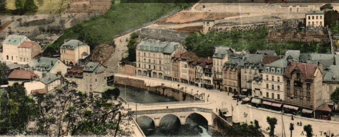
Tulle — Pont de la Barrière
